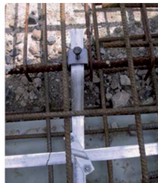
Εικόνα 9. Συνδετικοί Σφικτήρες για αγωγούς γείωσης σε σχημα ταινίας και ράβδου στον οπλισμό της σιδηροκατασκευής
