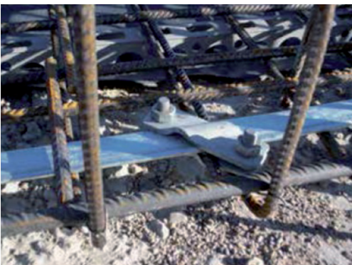
Εικόνα 9. Συνδετικοί Σφικτήρες για αγωγούς γείωσης σε σχημα ταινίας και ράβδου στον οπλισμό της σιδηροκατασκευής
