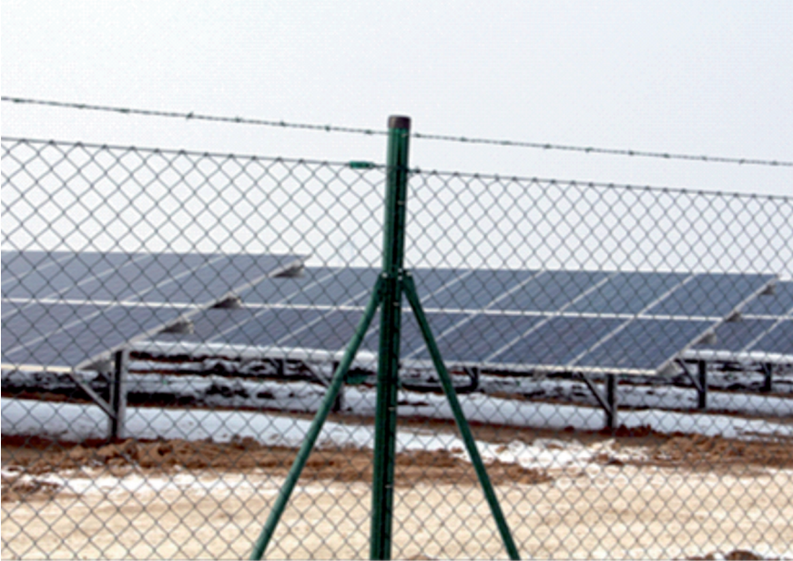
Εικόνα 31: Μεταλλικό κιγκλίδωμα για την περιφράξη Φ/Β-πάρκου
