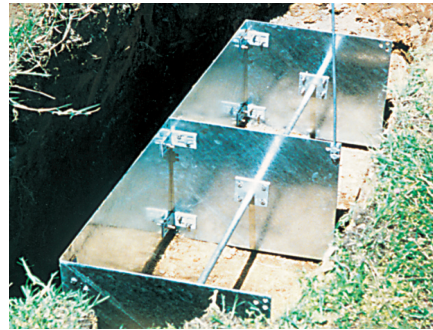
Εικόνα 5: Εγκατάσταση ηλεκτροδίων γείωσης πλάκας σε διαμόρφωση E.
